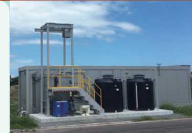
築上町液肥濃縮施設
